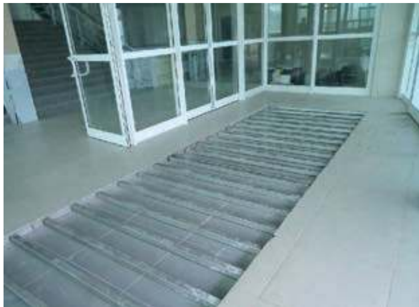
Рис. 18 – Схема монтажа половика в приямок глубиной 100 мм.
