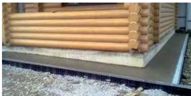
г. Владивосток, частный двор, пластиковые лотки со стальной оцинкованной решеткой
