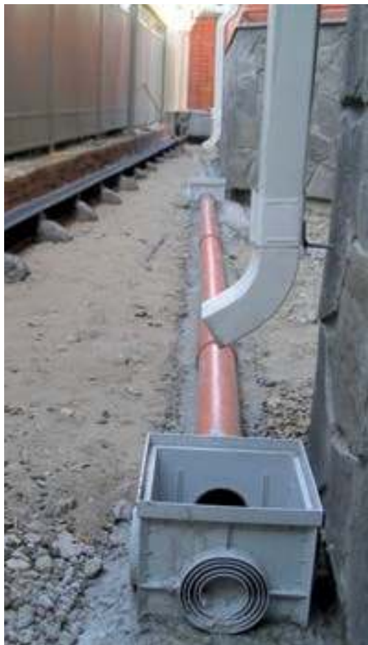
г. Краснодар, частный двор, монтаж дождеприемного колодца
