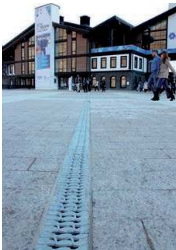
п. Красная Поляна, транспортный узел «Альпика-Сервис», пластиковые лотки с чугунной решеткой
