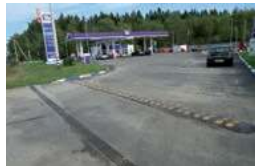
Московская область, АЗС «ТНК», пластиковые лотки с чугунной решеткой
