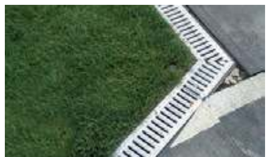
г. Жуковский, спортивный стадион, пластиковые лотки с оцинкованной решеткой
