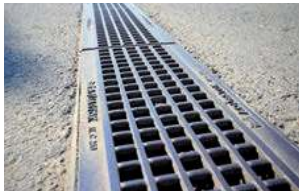
г. Краснодар, МЖК «Немецкая деревня», чугунная решетка пластикового канала
