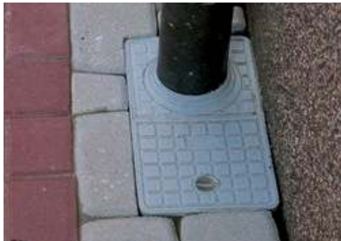
г. Санкт-Петербург, двор офиса, кровельный ливнеприемник
