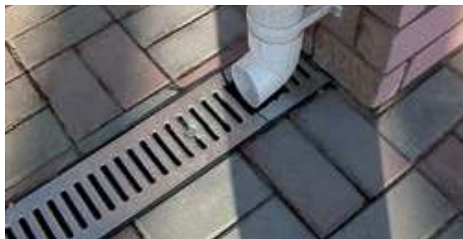
г. Нижний Новгород, частный двор, пластиковый лоток с оцинкованной решеткой
