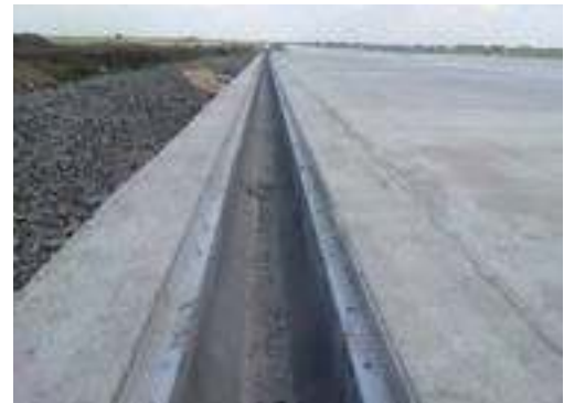
Краснодарский край, взлетно-посадочная полоса, бетонные лотки
