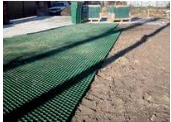
г. Санкт-Петербург, стоянка перед офисом, этап монтажа газонной решетки
